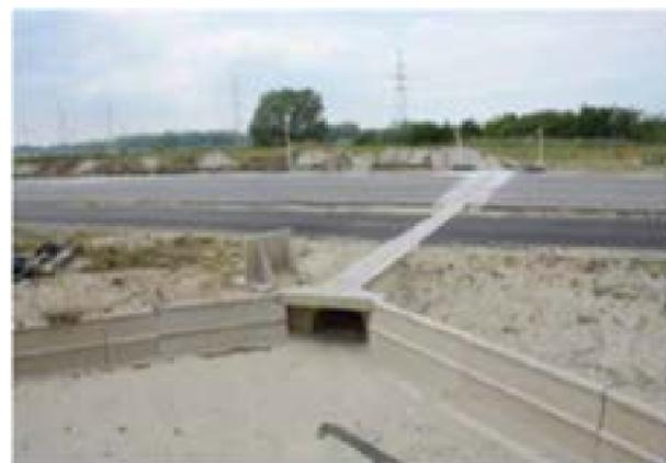
Figure 218 : Principe d'écoduc
